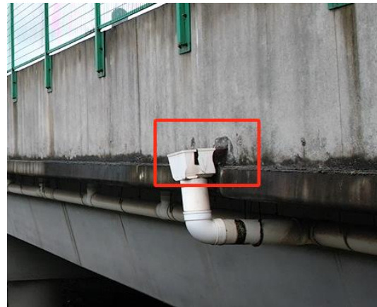
图 3-1: 雨水斗破损
